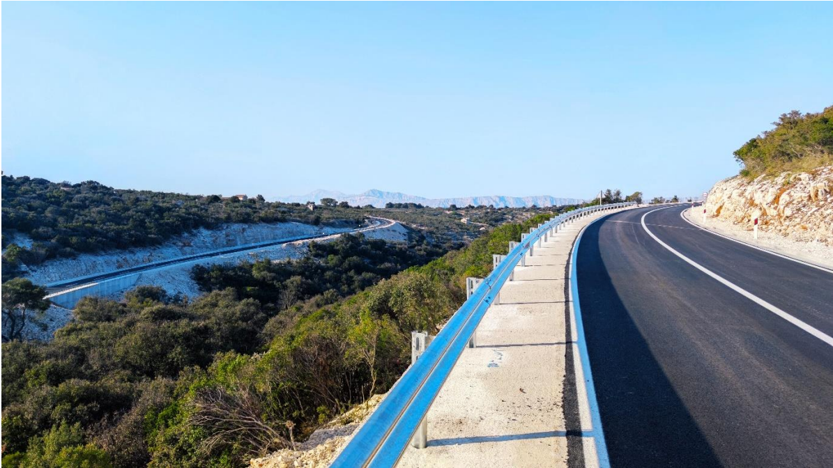
Foto: Cesta Pučišća-Povlja, dionica Pučišća-Uvala Luka, ožujak 2022.
